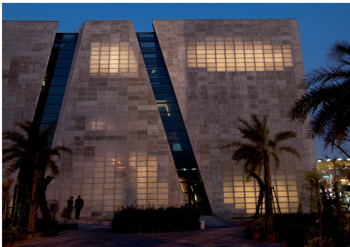
Le Pavillon italien réalisé pour l'Expo universelle de Shanghai en 2010 est le premier ouvrage à avoir exploité la technologie i.light.
